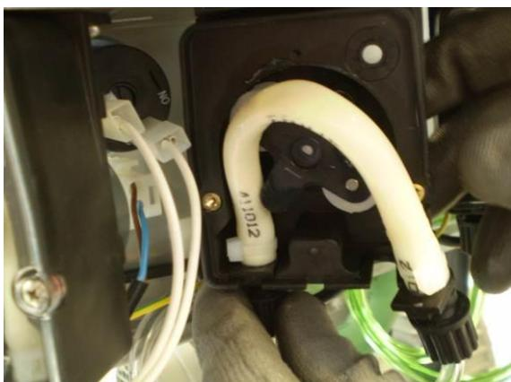
**ACHTUNG: Der Rotor der Dosierpumpe dreht sich nur gegen den Uhrzeigersinn!!!!**
